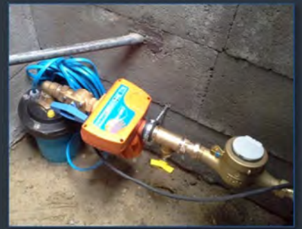
Aknában elhelyezett kút, szakszerű zárással, szivattyú vezérlővel és vízmennyiség mérővel
