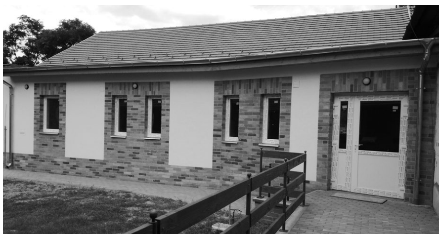
A veszélyhelyzet feloldásával elkezdődtek a felújítási munkák
